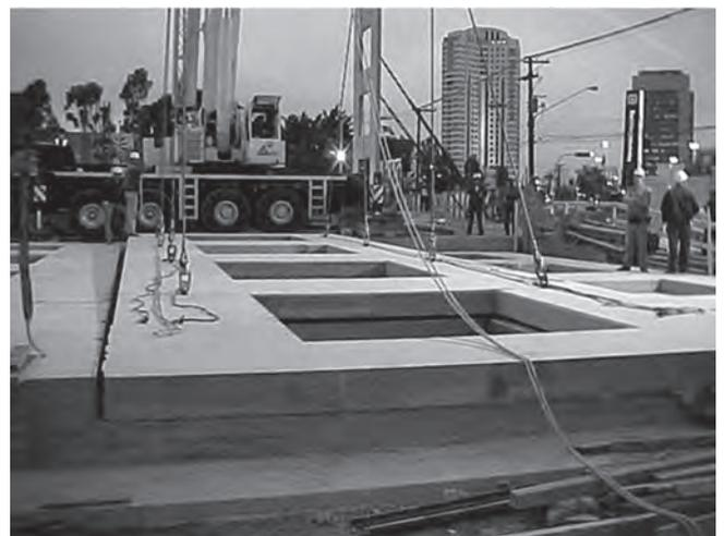
**Fig. 5.40** Exemplo de aplicação do processo construtivo *tilt-up* em edifícios de múltiplos pavimentos
