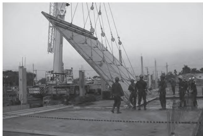
**Fig. I.20** Processo construtivo *tilt-up*
