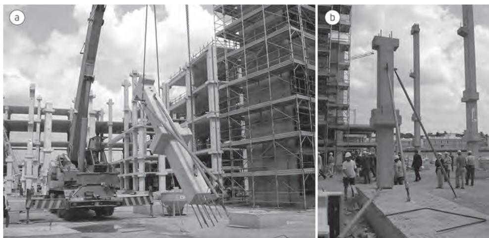
**Fig. 1.36** Exemplo de dispositivo auxiliar de montagem de pilar: a) montagem com o dispositivo e b) montagem com o dispositivo fixado
