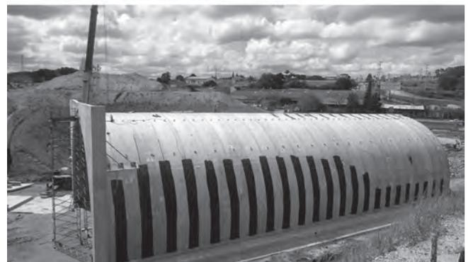
**Fig. 11.17** Exemplo de galeria em arco com seção formada por dois segmentos
