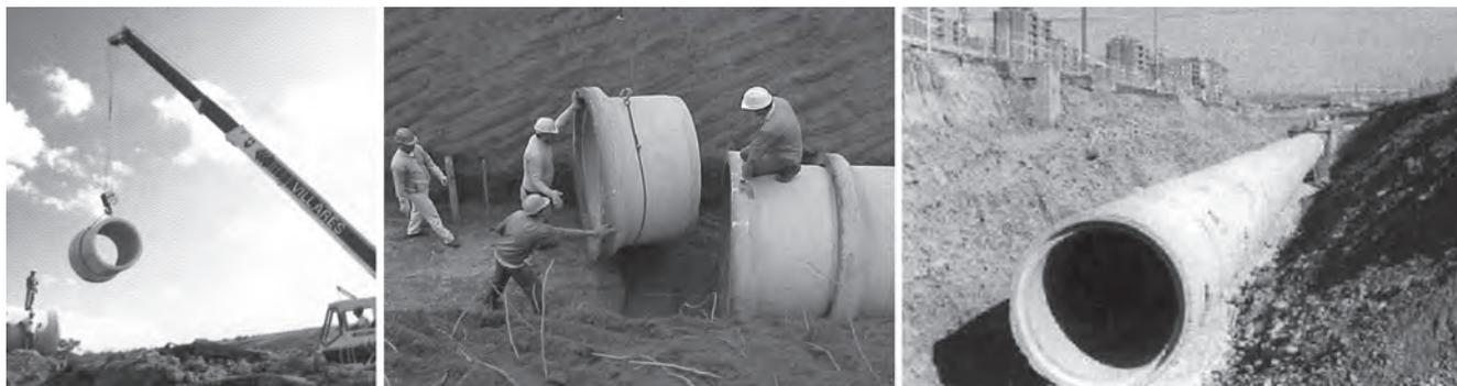
**Fig. 15.10** Montagem de linha de tubos circulares de concreto
