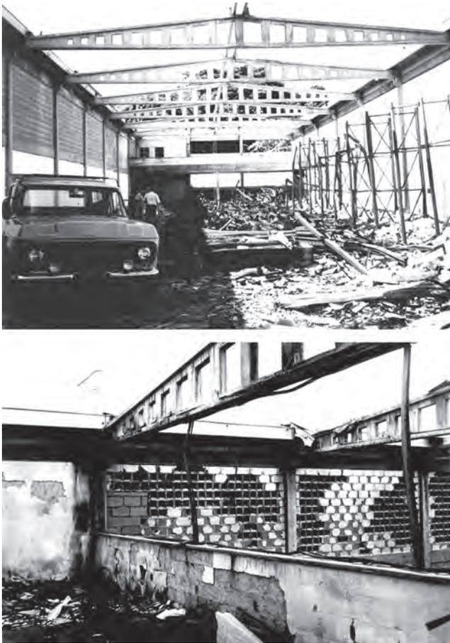
**Fig. 5.39** Viga de CPM após incêndio
