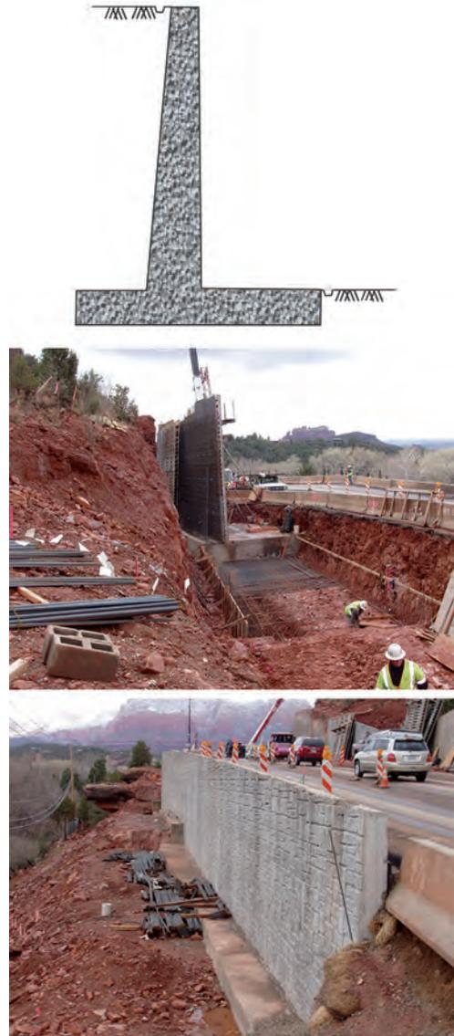
Fig. 6.10 Muros de flexão
