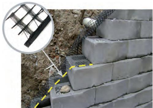
Fig. 8.49 Implantação errada da geogrelha
