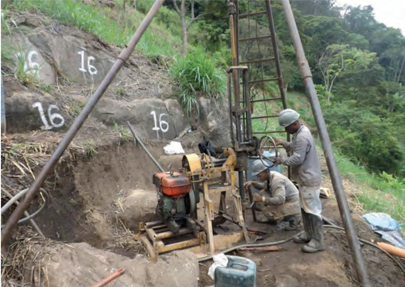
Fig. 5.5 Sondagem rotativa
