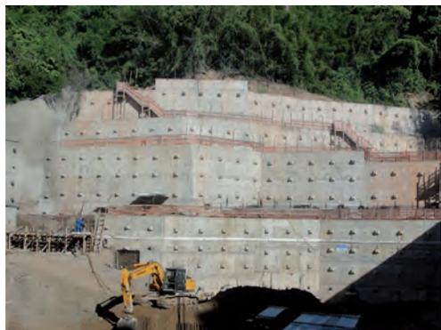
Fig. 7.3 Cortina atirantada na estabilização de um corte com mais de 30 m de altura
