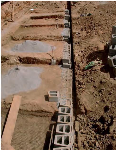
**Fig. 8.37** Implantação da base em camadas niveladas
