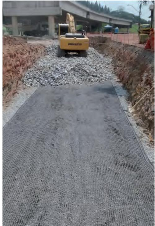
Fig. 8.31 Reforço da fundação do muro de solo reforçado com geogrelha e rachão
