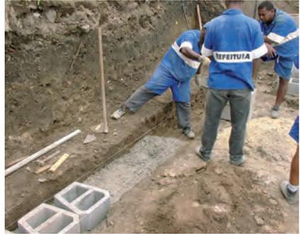
**Fig. 8.36** Assentamento da primeira camada de blocos
