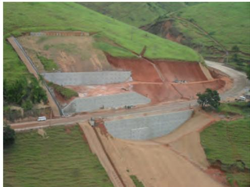
Fig. 7.2 Cortina atirantada na recomposição de uma rodovia
