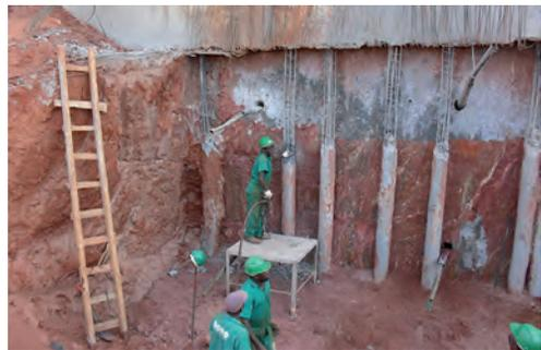
Fig. 7.10 Execução de um painel apoiado sobre estacas
