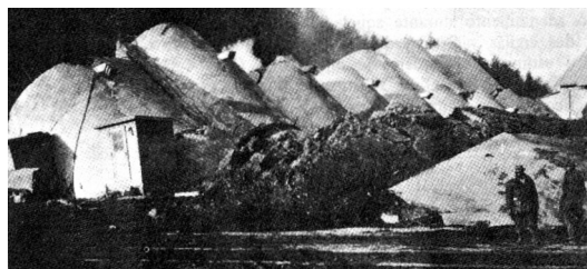
Fig. 1.1 Ruptura do solo de fundação de silos de concreto armado
