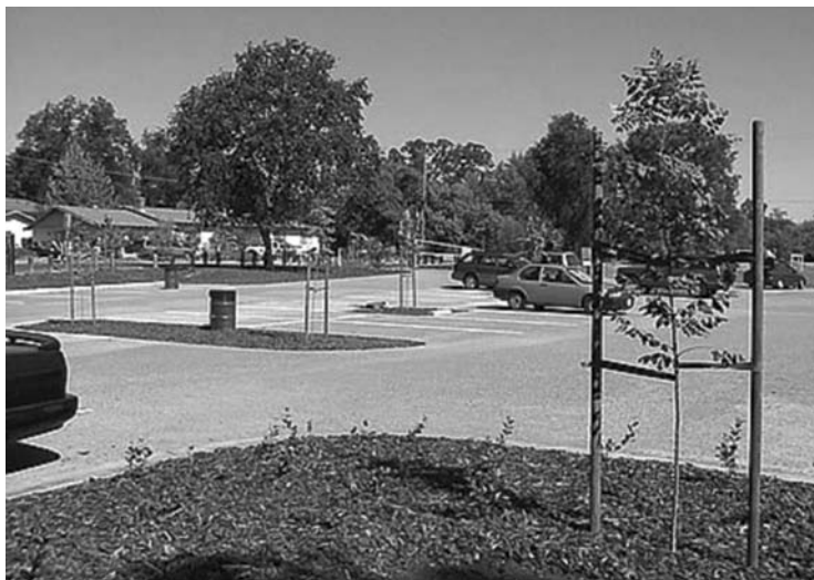
FIG. 6.13 Estacionamento com concreto poroso de Bannister Park, em Fair Oaks, Califórnia Fonte: Youngs, 2005.
