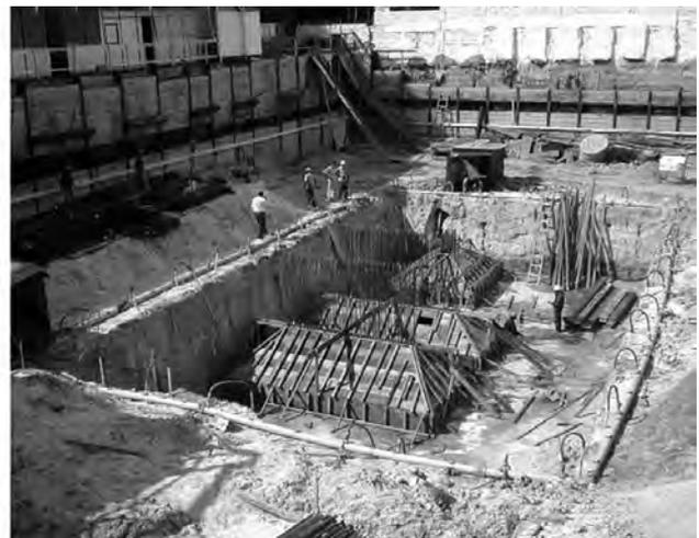
**Fig. 6.30** Fotos de sapatas isoladas
