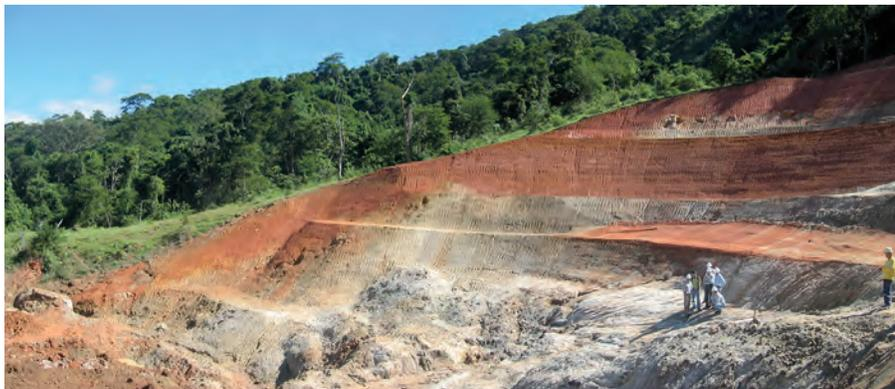
**FIG. 1.15** Perfil típico de solos residuais num maciço de gnaise, exposto por uma escavação com 40 m de altura, mostrando o solo laterítico (avermelhado) e saprolítico (amarelado), no Estado do Rio de Janeiro, Brasil
