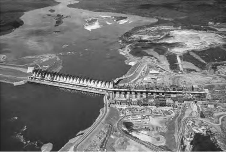
**Fig. 11.4** UHE Tucuruí, vista aérea das obras com desvio do rio pelas adufas sob o vertedouro
