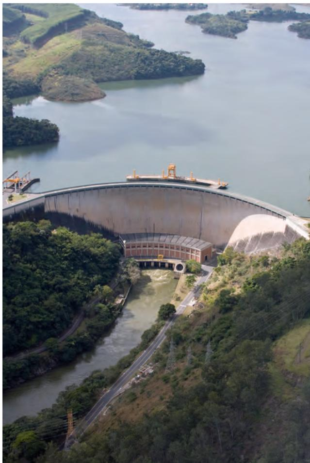
**Fig. 9.17** UHE Funil (rio Paraíba do Sul, RJ), vista de jusante. Observar detalhe do bloco da válvula dispersora, tipo hollow-jet ou Howell-Bunger, junto à margem esquerda
