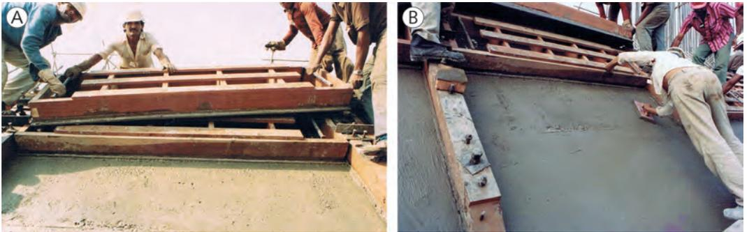
**Fig. 11.11** Construção do vertedouro da UHE Tucuruí, exemplo de forma temporariamente fixa (camadas 24 a 28). Remoção de painel: (A) notar aspecto da superfície do concreto e (B) início do acabamento da superfície com desempenadeira de madeira
