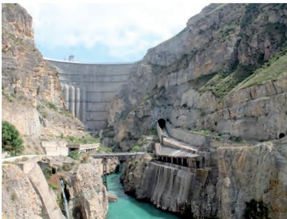
**Fig. 6.29** Usina Chirkreysk, vista de jusante. Observar saída do vertedouro em túnel na margem esquerda
