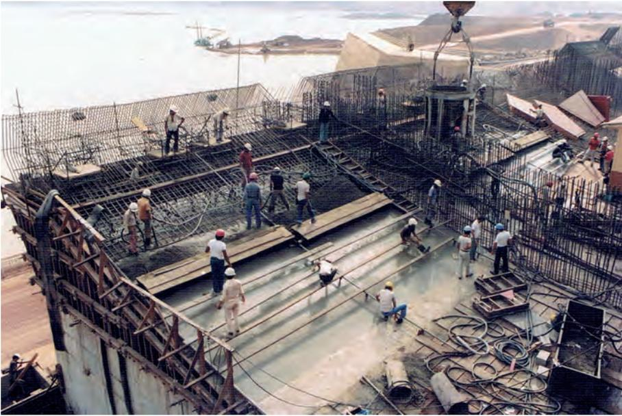
**Fig. 11.10** UHE Tucuruí, construção do vertedouro: concretagem da camada 21 jusante, utilizando-se forma deslizante
