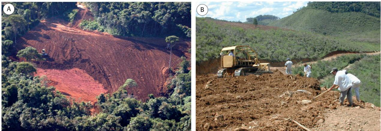
**Fig. 8.11** Distribuição da camada de solo superficial florestal em áreas a serem restauradas, com o uso apenas de trator (A) ou com trator e ajuda adicional de trabalhadores com enxadas (B)
