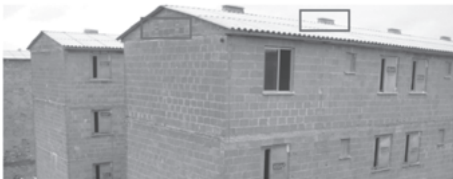
Figura 1.11 Posições dos dutos das aberturas horizontais e dutos verticais de ventilação da cobertura.
