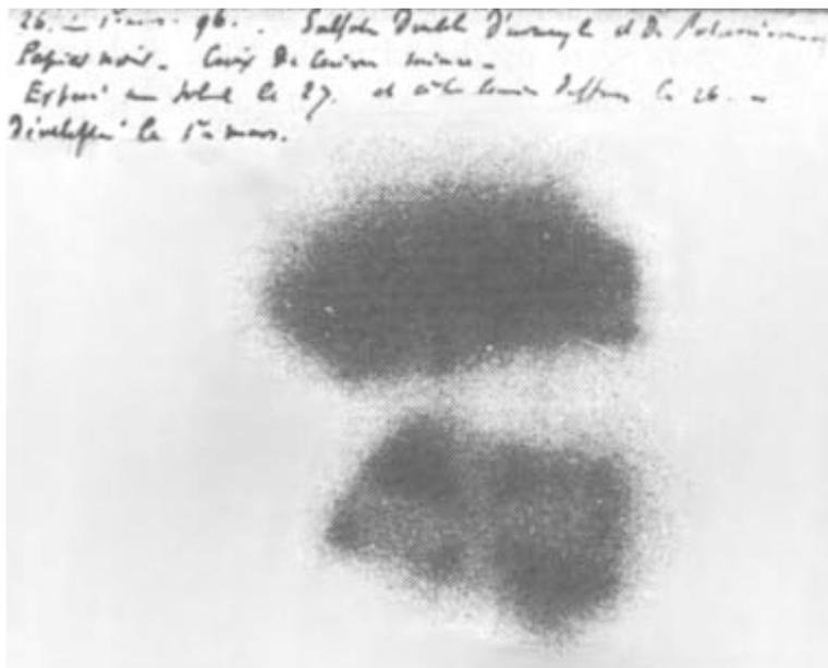
**Fig. 4.1** Radiografia com o contorno dos dois cristais de sulfato duplo de urânio e potássio, e de uma cruz de cobre interposta entre um dos cristais e o filme. As anotações são do próprio Becquerel
