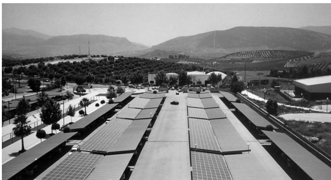
Fig. 2.3 Sistema fotovoltaico integrado a um estacionamento (geração de eletricidade ao mesmo tempo que fornece sombra aos carros)
