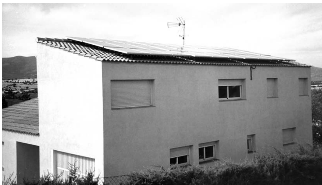
Fig. 2.2 Sistema de 5 kWp, integrado a uma edificação residencial (Soto del Real, Madri, Espanha)
