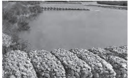
**Fig. 9.50** Espigão construído em água somente com gabiões saco
