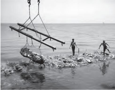
**Fig. 9.47** Colocação em água de gabiões saco
