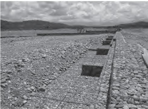
**Fig. 4.29** Proteção de margem com gabiões caixa forte® na Bolívia
