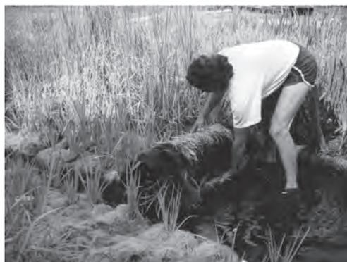
**Fig. 6.10** Geomanta reforçada pré-vegetada durante a instalação em água
