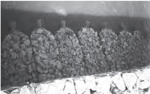
**Fig. 9.49** Gabiões saco colocados em água já na parte emergida
