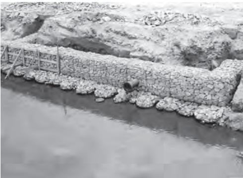
**Fig. 4.30** Muro em gabiões caixa fundado sobre uma base de gabiões saco colocados em água
