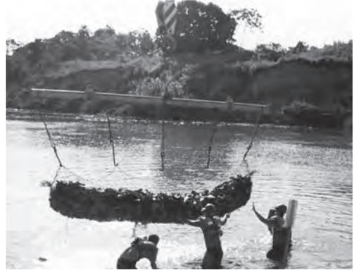
**Fig. 9.48** Gabiões saco sendo colocados em água
