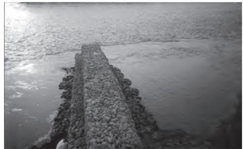
**Fig. 9.51** Espigão em gabiões construído em água em duas etapas: abaixo da água com gabiões saco e em seco com gabiões caixa
