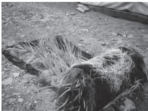
**Fig. 6.9** Geomanta reforçada já vegetada
