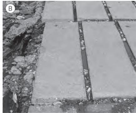
**Fig. 4.11** (A) Proteção de margem em construção e (B) seu detalhe
