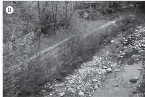
**Fig. 6.52** Córrego Mutino: estacas de salgueiro inseridas nos gabiões com padrão irregular em 2001
